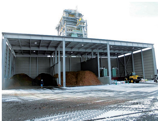
写真2 チップ貯留ヤード
