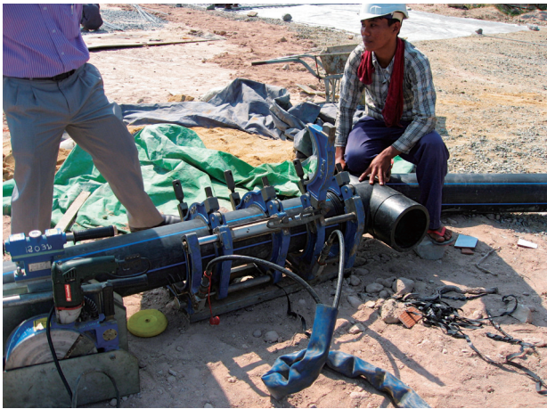
写真2 HDPE 管敷状況
