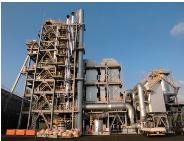
写真1 木質バイオマス発電所全景
