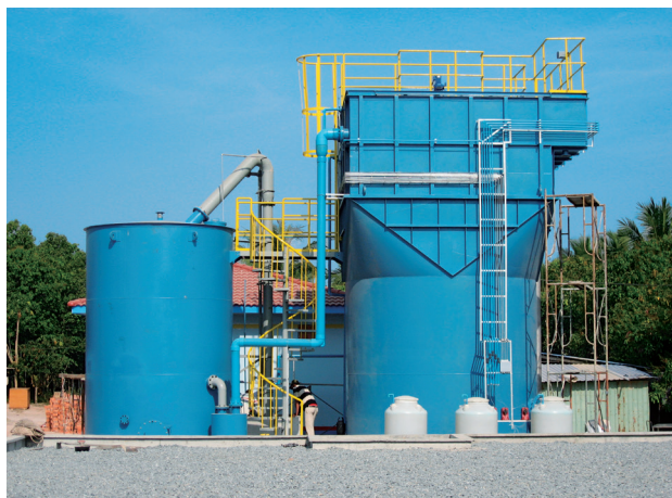
写真1 浄水処理装置
