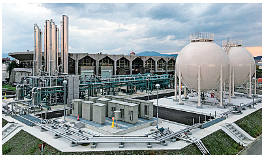
ガス精製装置 外観写真
