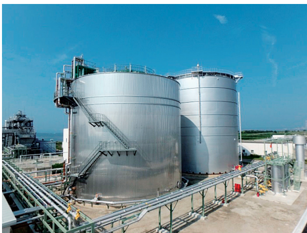
写真1 鋼板製消化槽 (左) (右はガスタンク)
