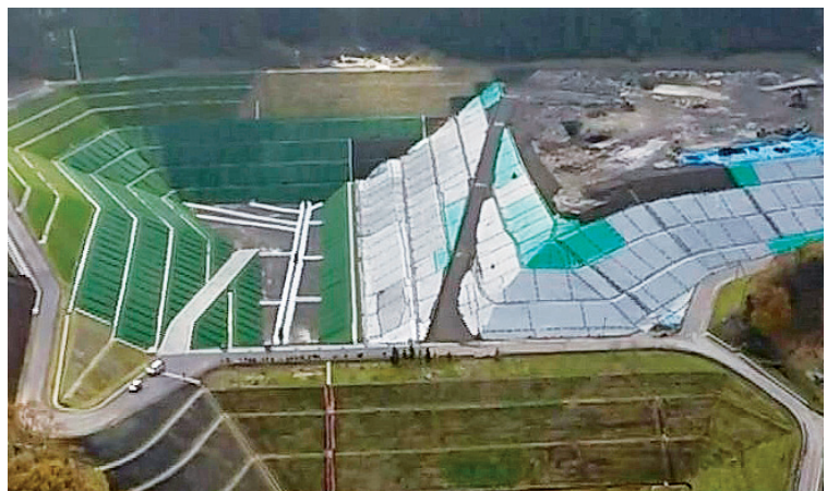
写真1 最終処分場全景
