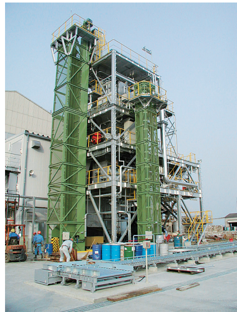
図7 ドラム缶破碎システム全景
