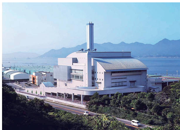
写真1 施設全体写真
