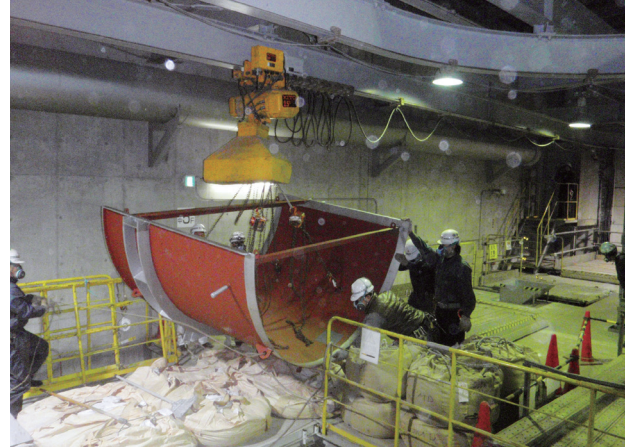
写真3 ガス冷却室分割搬入の様子
