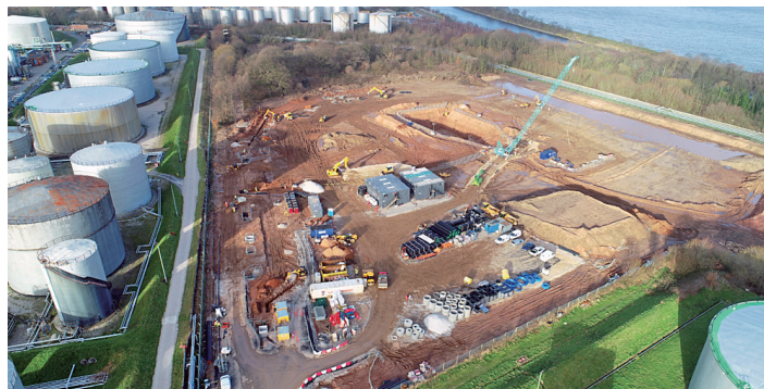
現地工事の進捗状況 (出典： https://www.cogenuk.com/projects )
