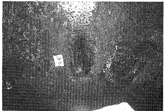
写真4 ステンレスクラッド鋼製ジャケット内面に生じた異常局部腐食 Photo. 4 Unusual localized corrosion occurred in the internal surface of stainless steel clad jacket
