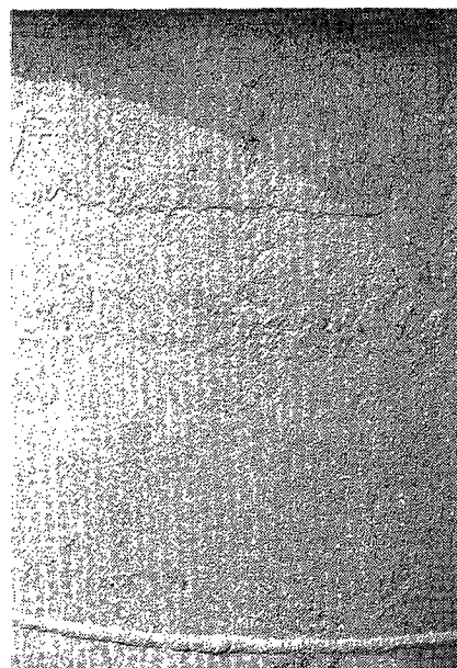
写真 6 グラスライニング製反応缶ジャケット内高圧洗浄後の無電解 Ni めっき施工例 Photo. 6 Examples of electroless Ni-plating in a jacket of glass-lined reactor after high pressure cleaning.
