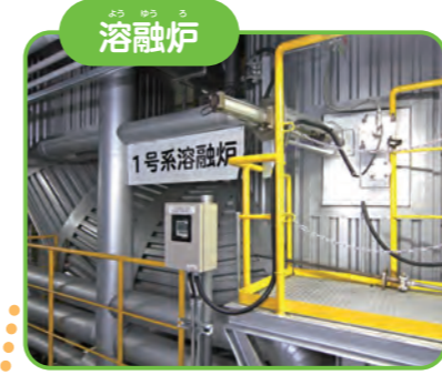
空気を吹き込んで1250℃くらいまで温度をあげて、灰を溶かしスラグにします。
