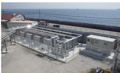
Wエコ発電（バイオガス350kW） 【垂水処理場】
