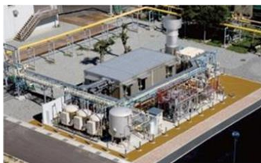
都市ガス導管注入 【東灘処理場】
