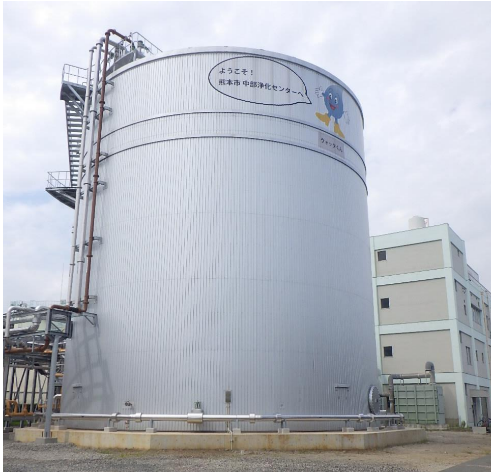
鋼板製消化槽の外観
