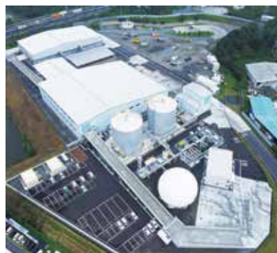
メタン発酵処理施設
