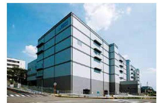
中間貯蔵・環境安全事業（株）豊田PCB処理事業所蔵向PCB処理施設
