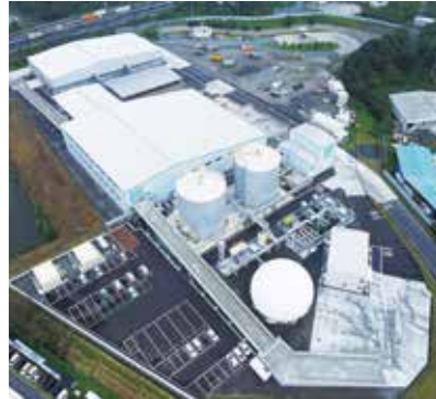
メタン発酵処理施設
