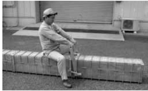
写真3 A/W有孔ブロックの接続
