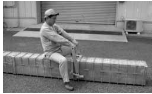
写真3 A/W有孔ブロックの接続
