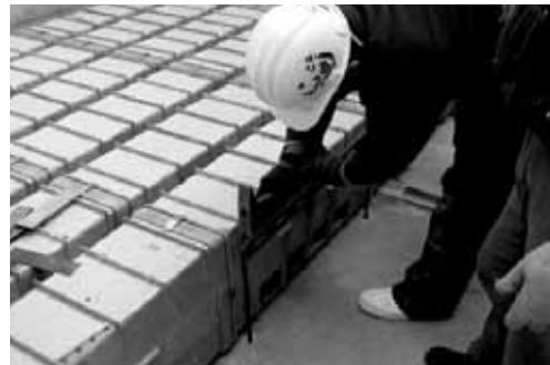
写真4 A/W有孔ブロックの据付
