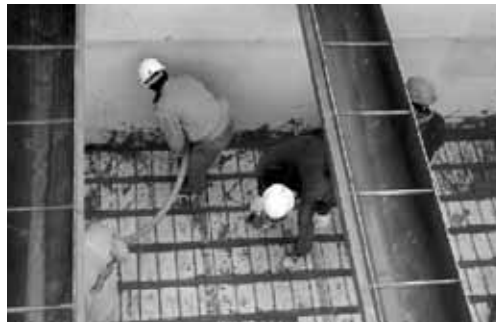
写真5 モルタル充填
