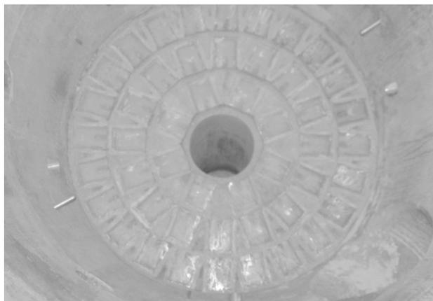
写真2 空気分散板
