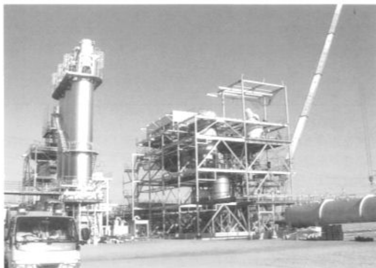
写真1 建設中の千葉工場（撮影日：2006.1.11）
