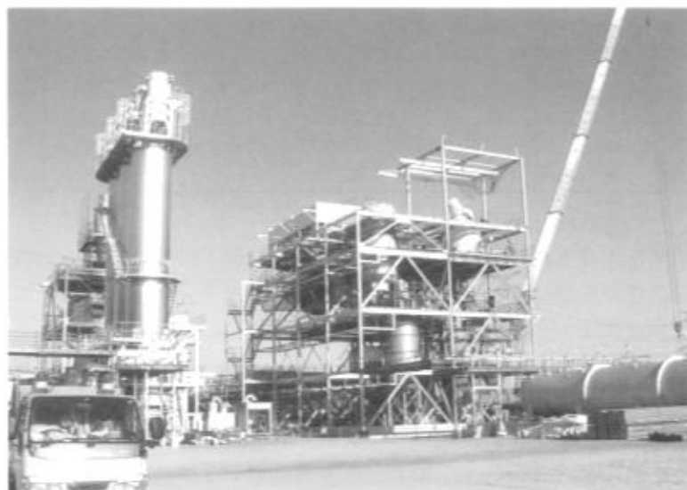
写真1 建設中の千葉工場（撮影日：2006.1.11）
