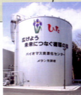
メタン発酵槽（1 900 m 3 ）
