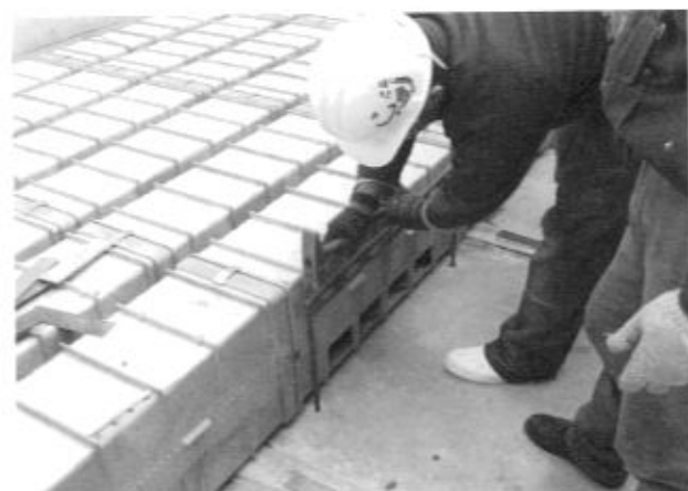
写真6 A/W 有孔ブロックの据付
