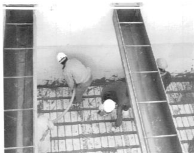
写真7 モルタル充填
