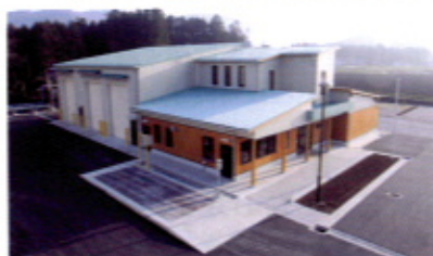
原料受入・管理棟
