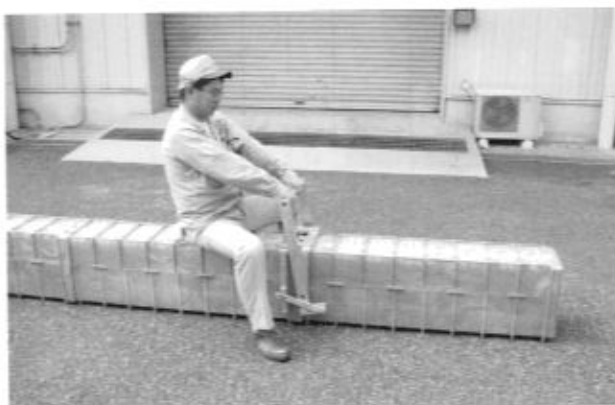
写真5 A/W 有孔ブロックの接続
