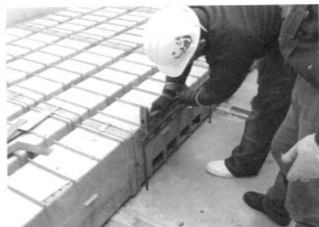
写真6 A/W有孔ブロックの据付
