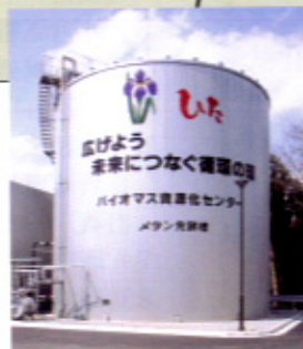
メタン発酵槽（1900 m 3 ）
