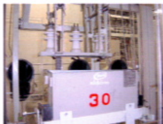
—解体ステーション— 汚染機器から PCB を抜き取り、 洗浄に適した形状に解体する
