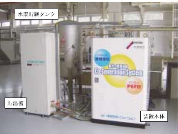
写真4 1 kW級固体高分子型水電解/燃料電池コジェネ装置（島根県松江市ソフトビジネスパーク内、ESS技術開発センター設置）
