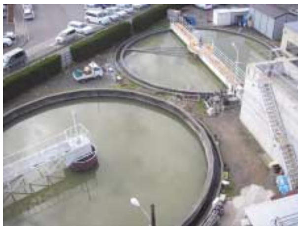
b) 最終沈殿槽（既設流用）
