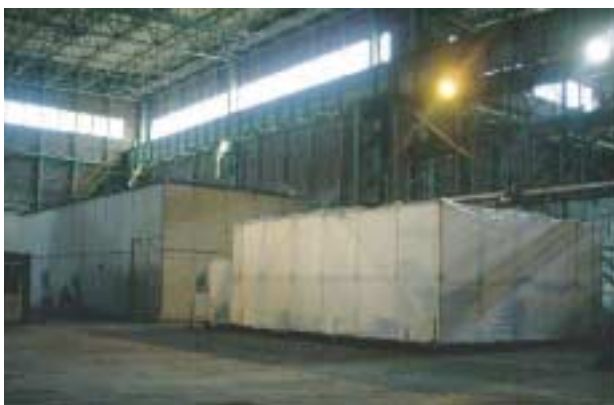
写真1 実験施設全景 (左奥；還元加熱設備，右手前；前処理設備)
