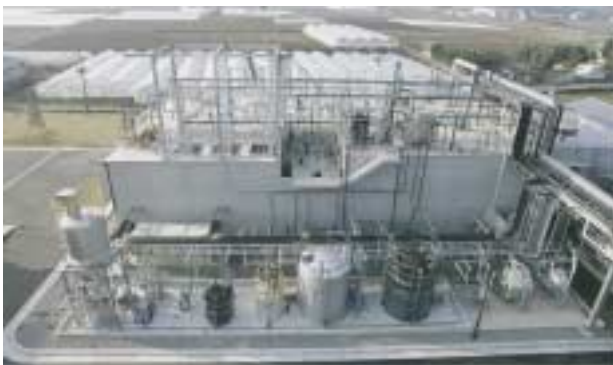
図6 排水処理設備外観
