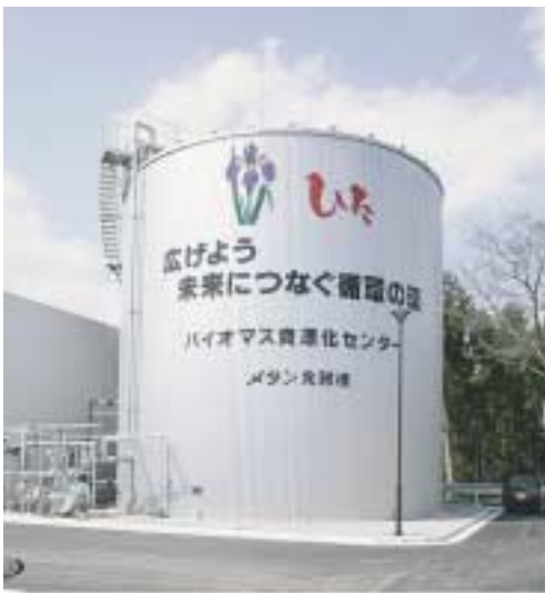
図5 メタン発酵槽外観
