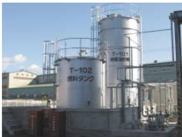
写真6 絶縁油貯槽および燃料タンク
