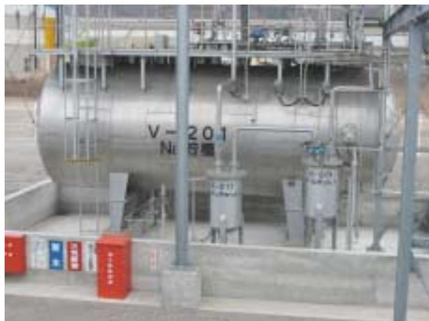
写真5 ナトリウム貯槽
