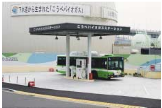
写真3 こうべバイオガスステーション
