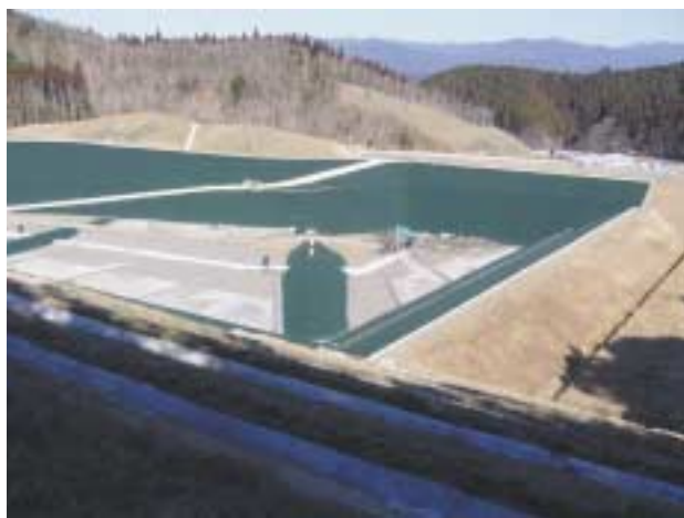
写真1 開業当時の処分場
