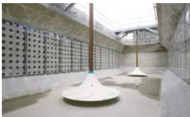
写真2 武庫川下流浄化センター据付状況
