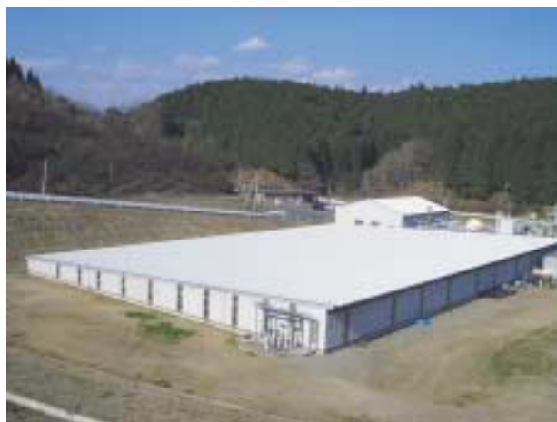
写真3 水処理設備全景
