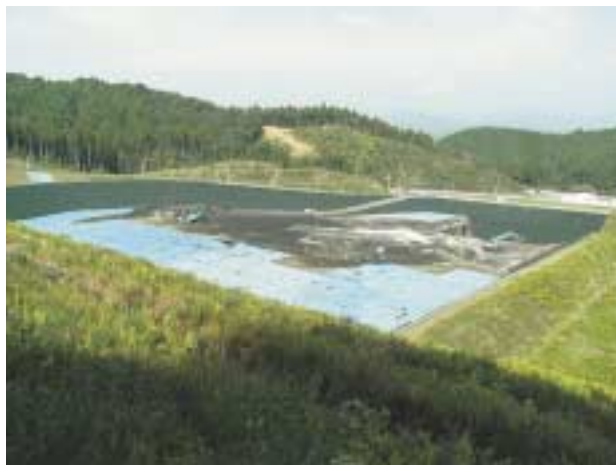
写真2 埋立進行中の処分場
