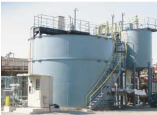
写真1 高速凝集沈殿装置の外観
