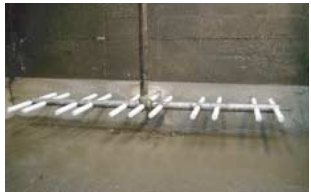
図3 チューブ型ニューエアーの測定箇所と配置写真 (N 浄化センター)
