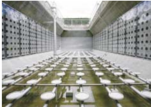
図2 ディスク型ニューエアーの測定箇所と配置写真 (M 浄化センター)
