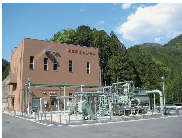
図8 浜松市城西浄化センター
