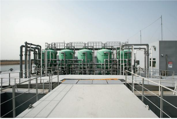
写真6 砂ろ過処理設備
