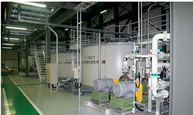
写真3 逆洗排水回収装置
