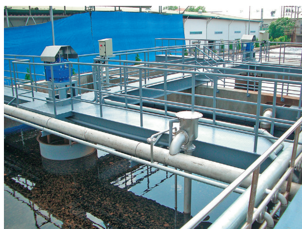
写真3 設備外観3（沈殿槽）
