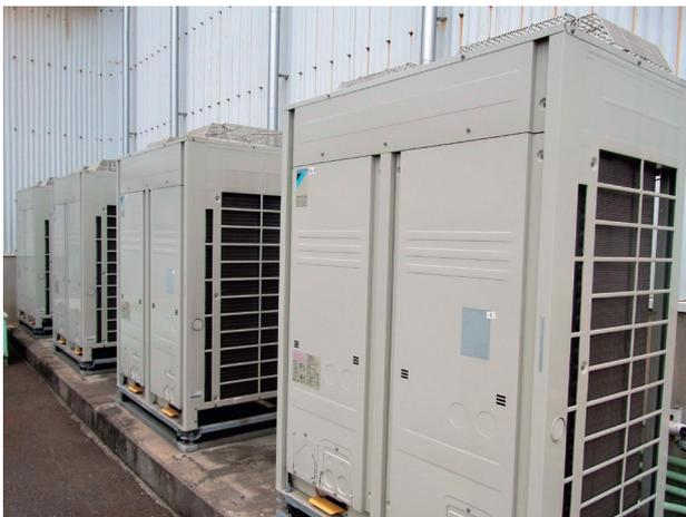
写真2 電気ヒートポンプ式空調
