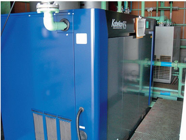
写真1 インバータ制御コンプレッサ
