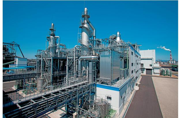
分解炉より排出される未燃分を含む排ガスは、二次燃焼室で完全燃焼させた後、熱交換器、排ガス処理装置を経てクリーンな排ガスとなり、煙突より排出される。
