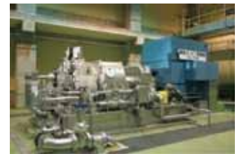
写真1 流動床式ガス化溶融施設の工場棟内 (相模原市南清掃工場:175 t/24 h × 3系列)
