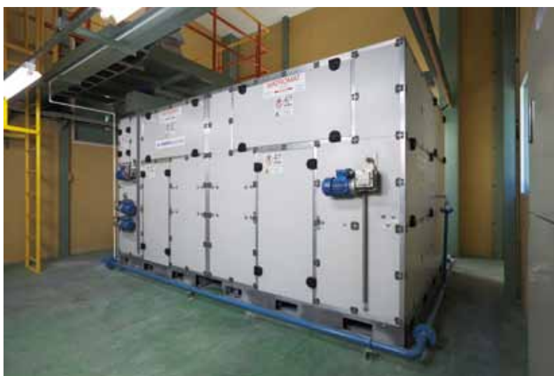
(株)神戸製鋼所 真岡製造所殿向け 乾燥能力 (除去水量) : 2.8 t/d
