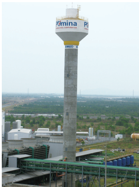
写真4 電炉用高架水槽
