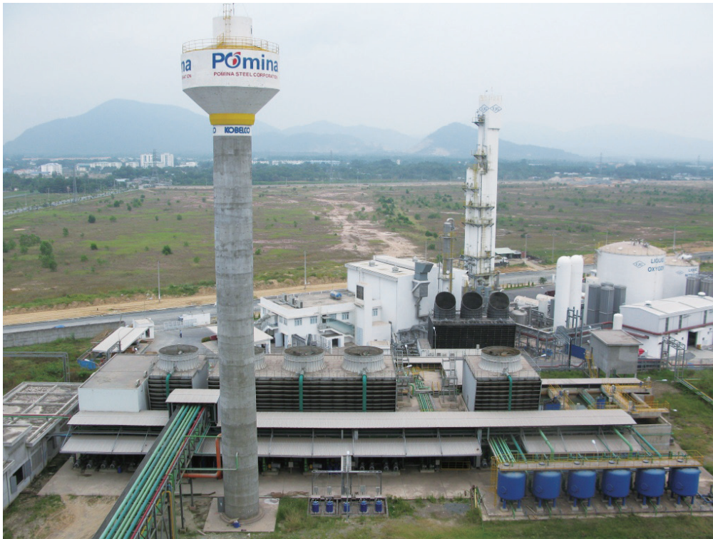
写真 1 水処理設備全景（前方設備）
