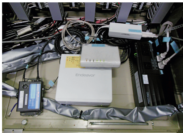
写真2 WaterEye 現場設置機器姿
