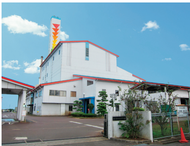
写真1 設備全体写真
