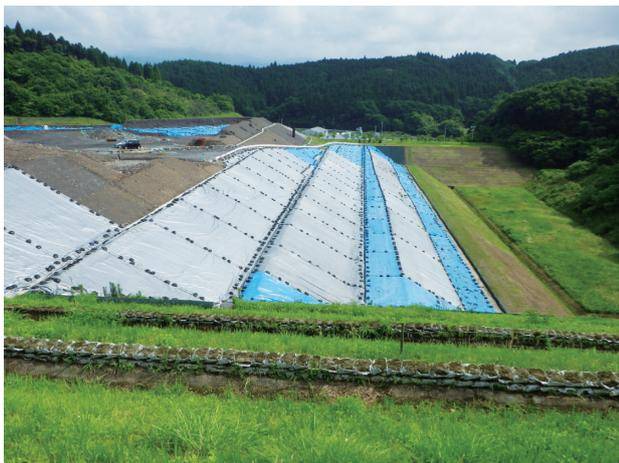
写真1 キャッピングによる雨水排除
