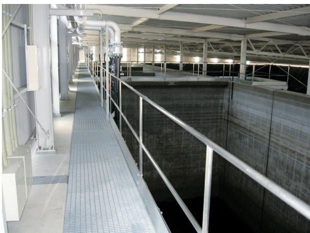
写真2 浸出水調整設備への屋根設置
