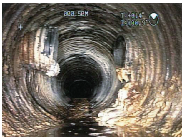
写真3 集水管清掃前
