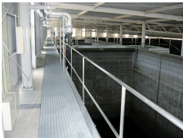
写真2 浸出水調整設備への屋根設置
