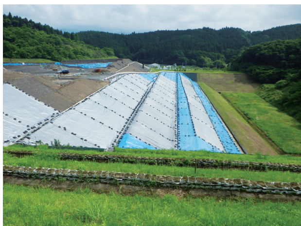
写真1 キャッピングによる雨水排除
