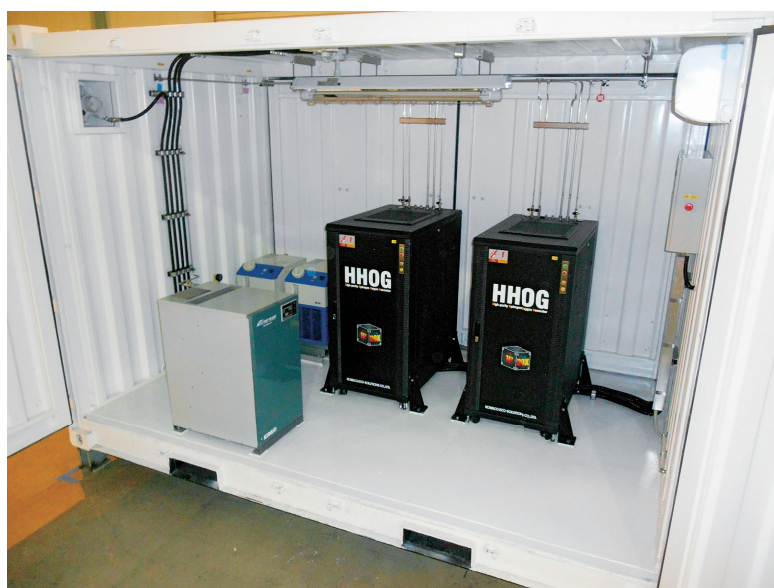
写真6 再生可能エネルギーを電源とする H 2 BOX の納入事例
