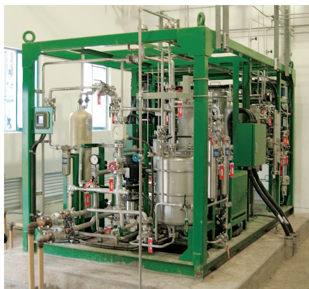
写真3 スキッドマウントタイプ HHOG SL-5D (5 Nm 3 /h)
