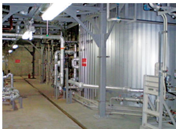
写真1 設備外観（メタン発酵槽）
