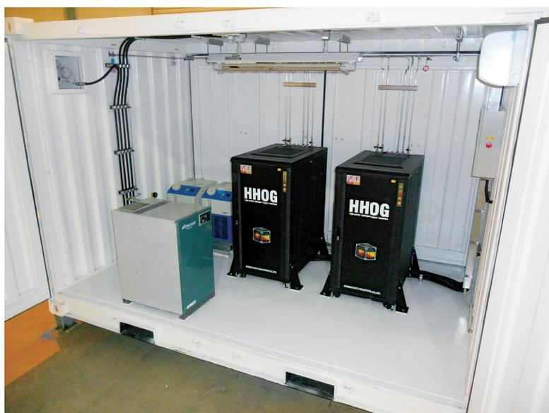
写真6 再生可能エネルギーを電源とする H<sub>2</sub>BOX の納入事例
