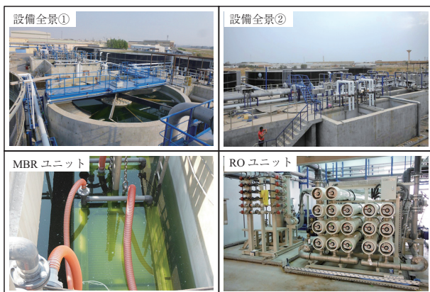
写真1 設備全景と主要機器外観
