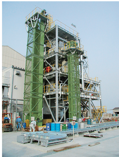
図7 ドラム缶破碎システム全景
