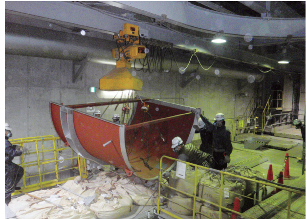
写真3 ガス冷却室分割搬入の様子
