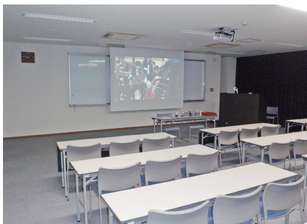
写真4 非常用電源に接続改造した研修室のテレビ
