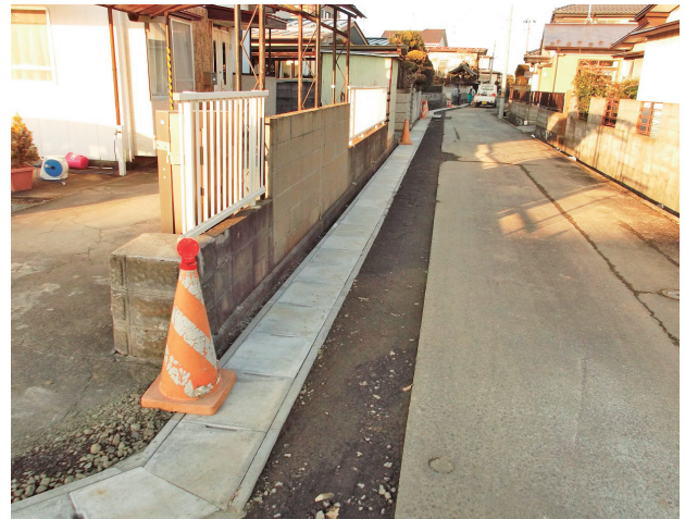
図9 溶融スラグ入り落ち蓋式U形側溝試験施工実施状況
