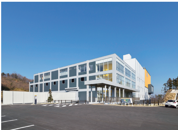
図1 仙南クリーンセンター
