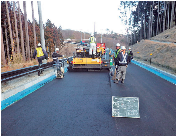
図8 溶融スラグ入り道路用アスファルトの試験施工状況
