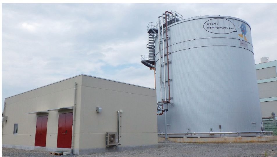
機械棟・鋼板製消化槽 外観写真
